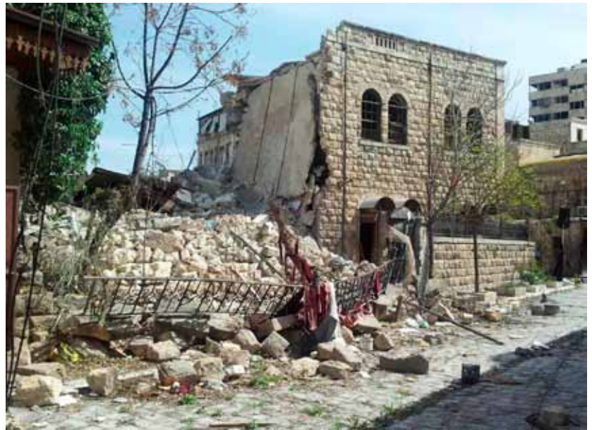
Bâtiment détruit de l'église presbytérienne d'Alep. Photo: NESSL
