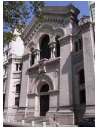
La célébration de la création de la nouvelle Église aura lieu au Grand Temple de Lyon (France).
